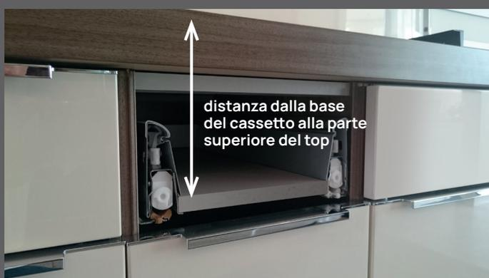
non siano sufficienti a compensare la differenza di altezza tra il supporto della macchina da incasso e il piano di lavoro, è possibile utilizzare un cartoncino o un pezzetto di truciolato per aumentare l'altezza della macchina.
